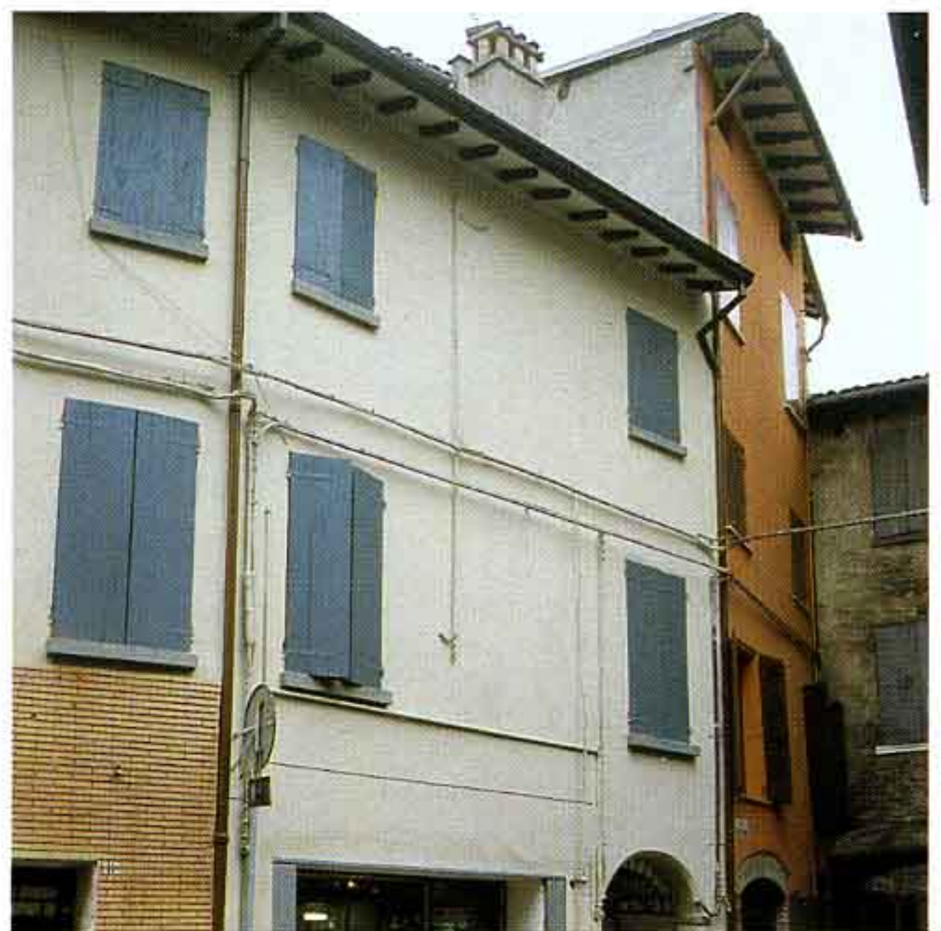
Fig. 44 - Edificio in via Felice Cavallotti n. 42/46. Intervento di tinteggiatura eseguito con materiali e tecniche tradizionali (tinte a base di calce).
