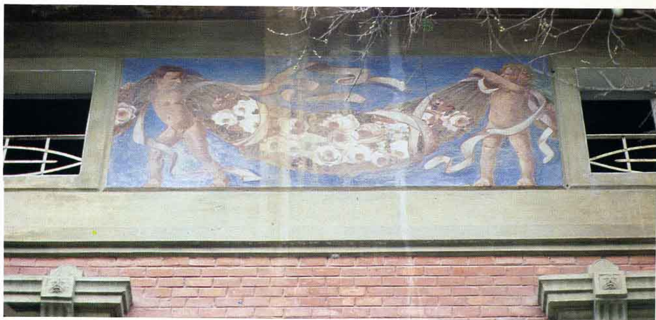
Fig. 24 - Via Menotti, Ospedale Civile. Particolare di intonaco lavorato a «mattonata» ad imitazione di cortina laterizia (fine sec. XIX).
