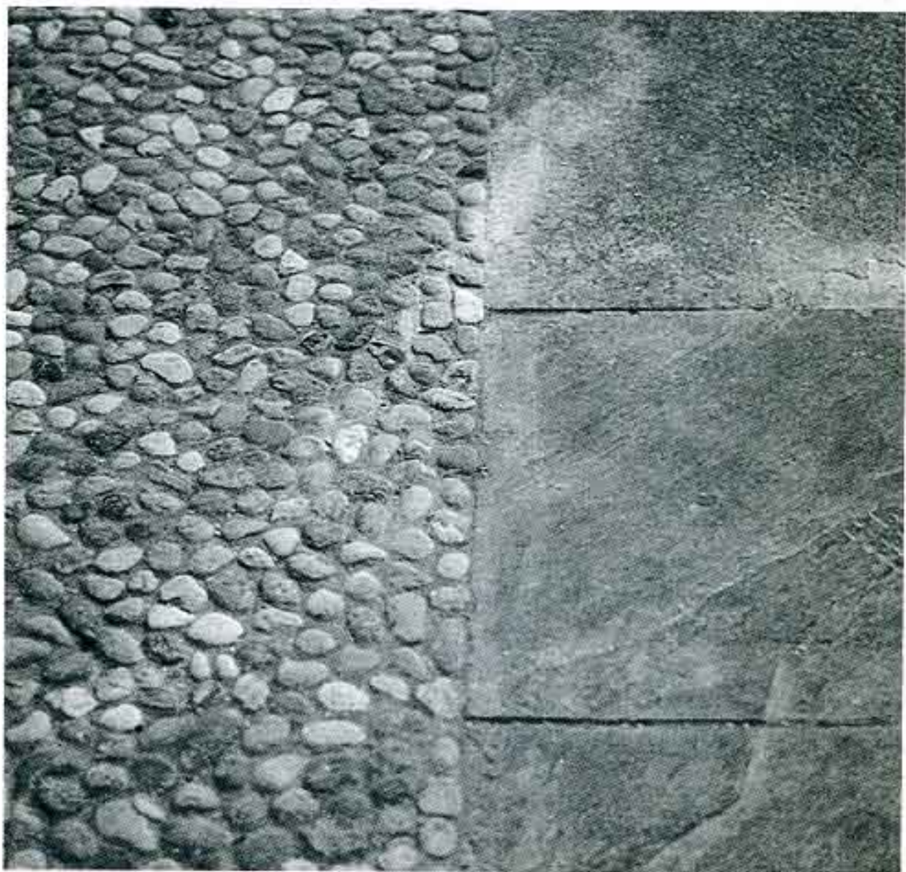
Fig. 49 - Piazza Garibaldi. Pavimentazione in porfido a lastre squadrate.
