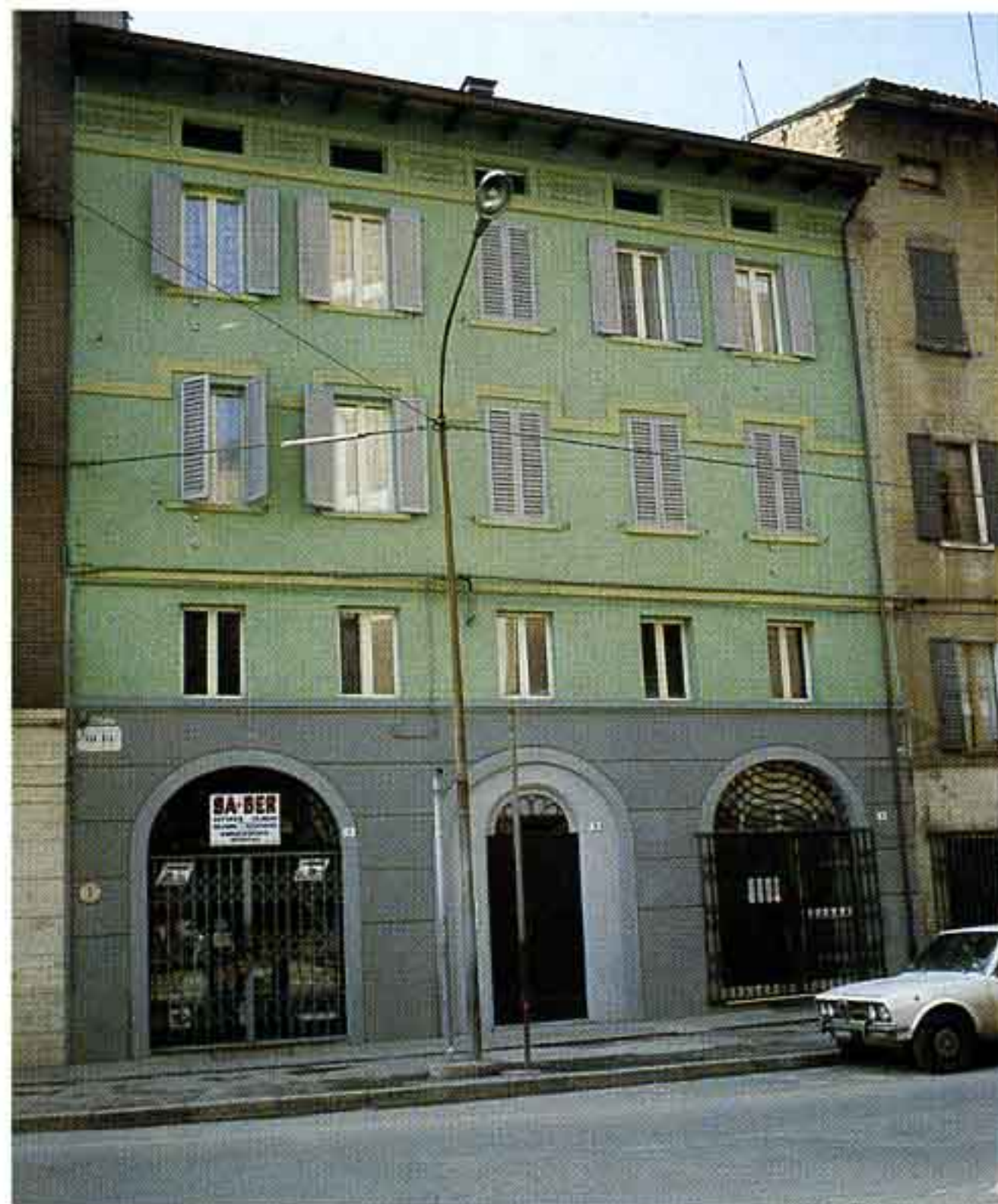
Fig. 38 - Edificio in Via Pia n. 1/5. Intervento di tinteggiatura eseguito con tinte al quarzo.
