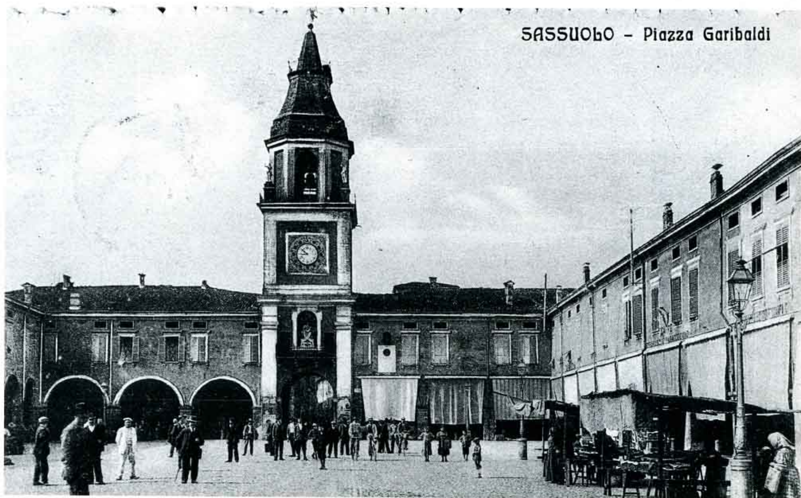
Fig. 62 - Piazza Garibaldi, prima dei lavori di restauro delle facciate e alle decorazioni (1929-30). Fotografia 1910 (circa). Collezione Roberto Costi.
