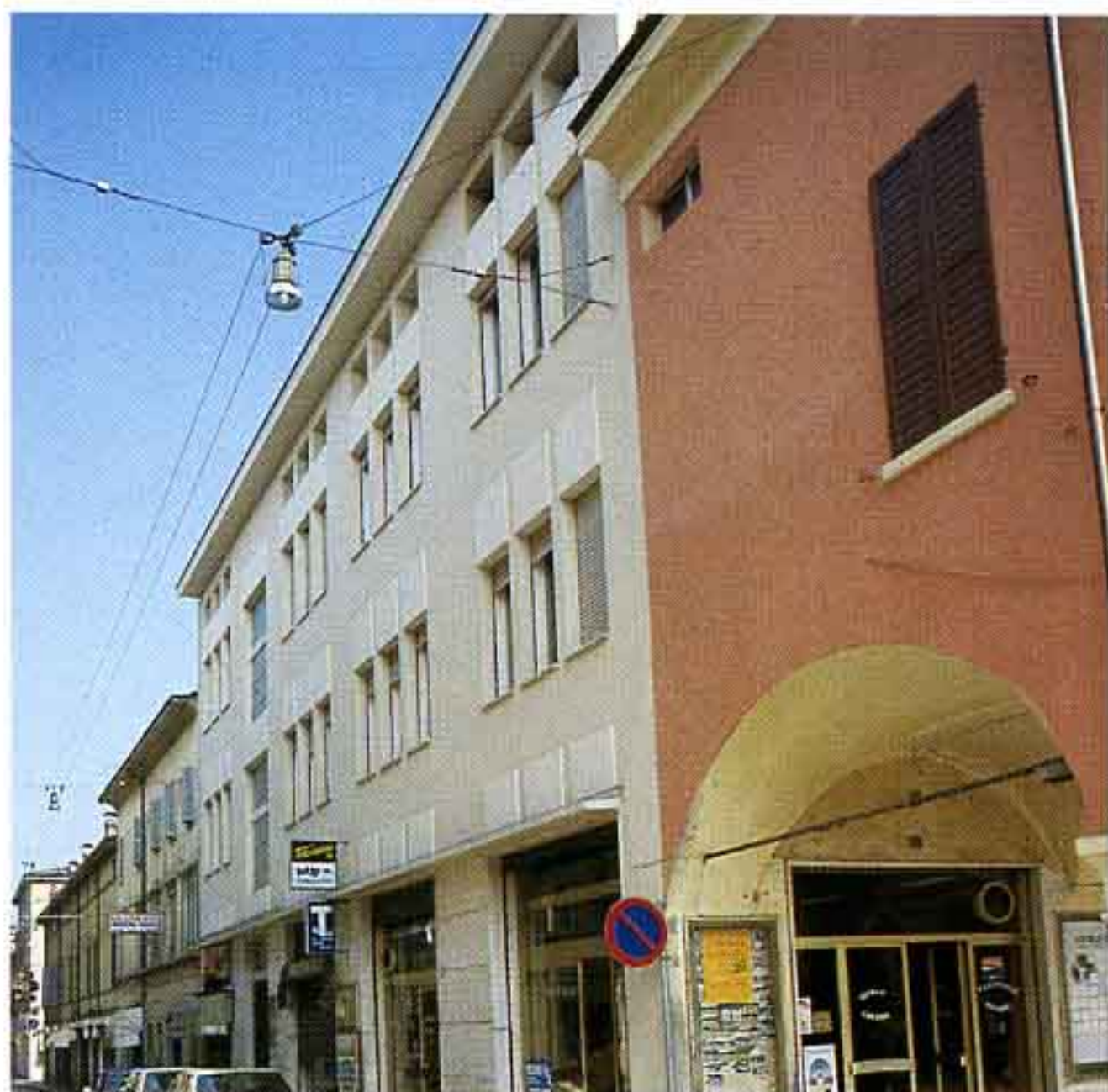
Fig. 39 - Edificio in via Caula n. 30/48. Intervento di tinteggiatura eseguito con tinte a base di silicati.
