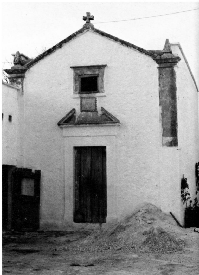
Chiesa della masseria "Guappi". Esterno.
