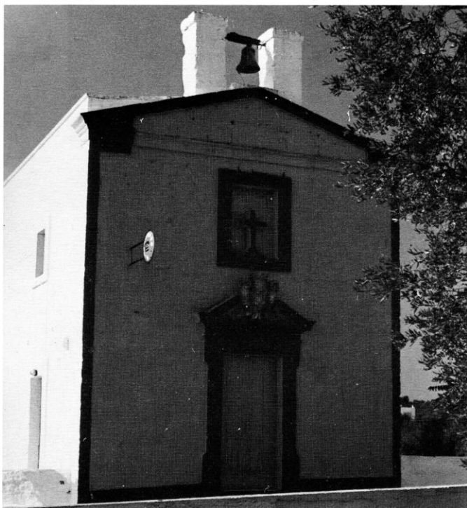
Chiesa della masseria "Barbagianni". Esterno.
