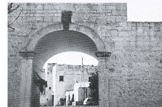
Portale di ingresso della masseria (Fonte: A. Sozzi, Le masserie di Ostuni, Schena Editore, Fasano di Brindisi 1991)
