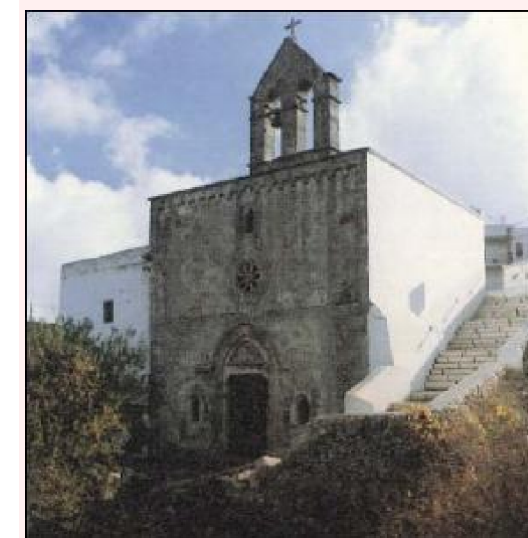
La facciata principale
